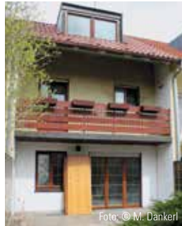
Das Reihenmittelhaus vor der Sanierung
